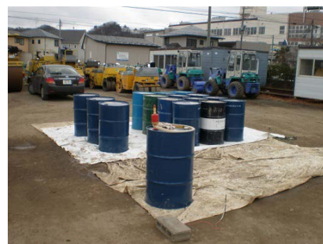
【ドラム缶による燃料の一時的な貯蔵例】
